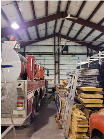
Fig. 17. Destratification fan
